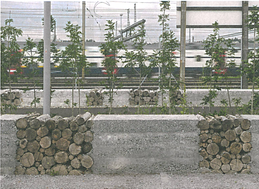
Umgebung Letzibach in Zürich-Altstetten: Holzstämmen für Kleinlebewesen sind in Stampfbetonmauern eingelassen.
