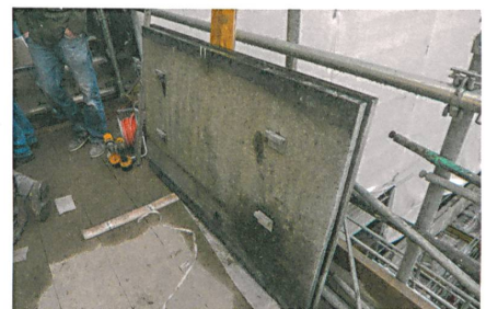
Steinplatten mit Agraffenhalterung.
