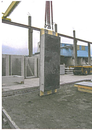
Fixfertig kommen die geschosshohen und tonnenschweren Sandwichelemente.
