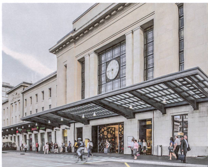
Am Übergang vom Art déco zur Moderne: die Fassade des Genfer Bahnhofs Cornavin.
