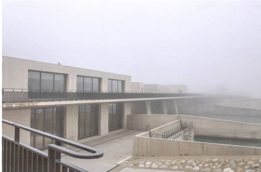
Volumetrische Klammer: Die wasserumspülten Wehrpfeiler sind geneigt und springen beim Brückenaufleger zurück. Das Maschinenhaus und der Schlusspfeiler sind höher, breiter und gerade.
