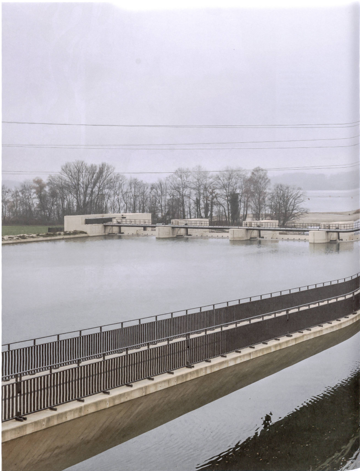
Wasserkraft und Szenografie am Bielersee: Ein Wanderweg führt beim Kraftwerk Hogneck über eine 75 Meter lange Brücke, um das Maschinenhaus herum und der Staustufe entlang.
