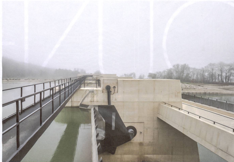
Beim neuen Kraftwerk Hagneck liegt die Wehrbrücke rechts unter dem Stauwasser. Eine massive Brüstung wirkt schützend, zum See ist das Geländer aus Stahl. Der Dienststeg links verbindet die Pfeiler über dem Oberwasser.
