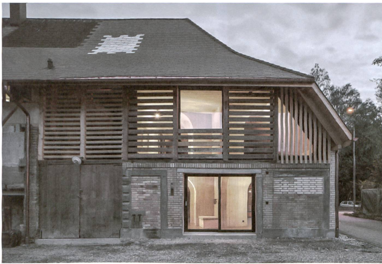
Umgebautes Bauernhaus in Rüegsauschachen: Die Nordfassade ist ein Patchwork, und in der Nacht zeigt sich die innere Skulptur.
