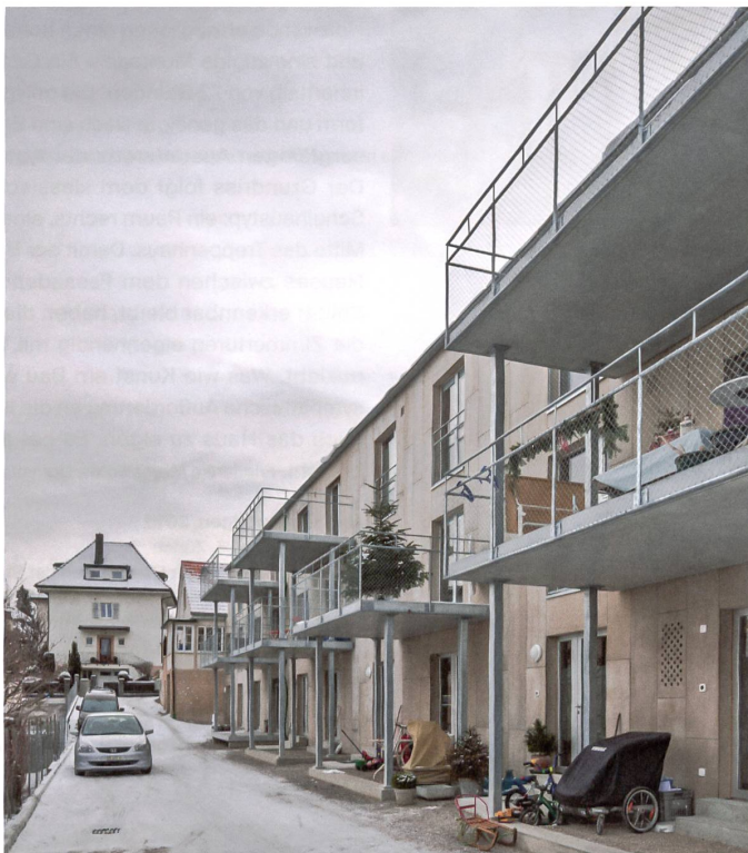
Direkte Erschliessung, direkter Aussenraum: Kies vor den Haustüren.
