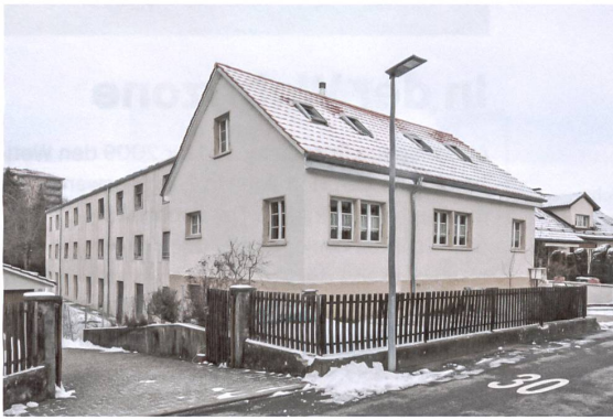
Chemin des Grottes in Freiburg: Das bescheidene Haus von 1930 hat man sorgfältig saniert und mit einem Anbau erweitert.
