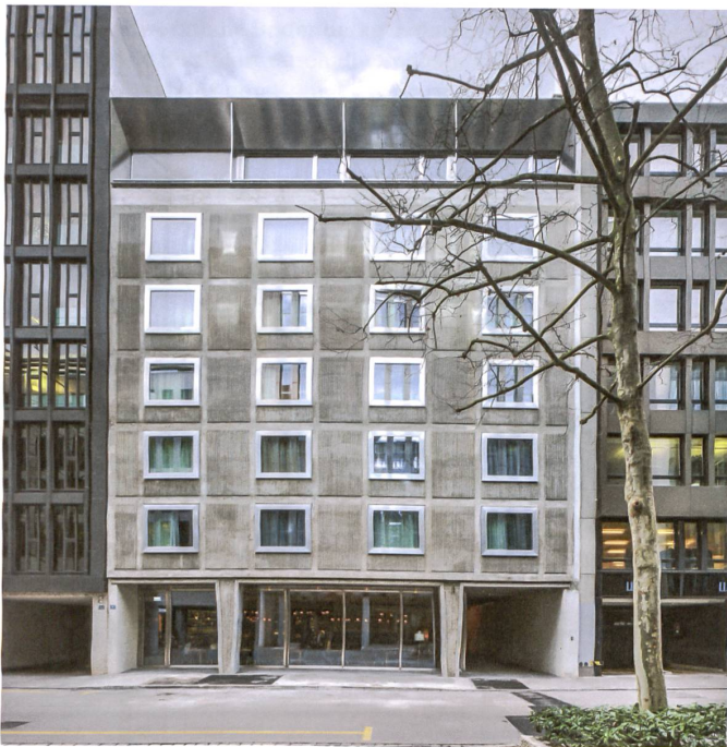
Die geriffelte Betonfassade des Hauses am Brunnngässlein 8 in Basel. Sie war lange Zeit unter einem braunen Anstrich verborgen und ist vorsichtig mit Wasserdampf von der Farbe befreit worden. Ganz oben ist ein hellerer Streifen sichtbar: Der erste Versuch mit Sandstrahlen waren zu aggressiv.
