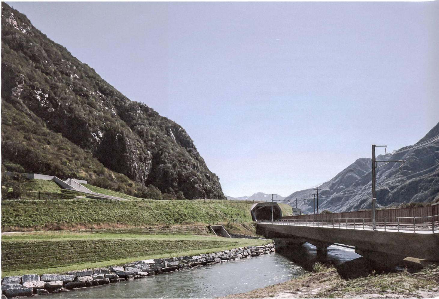
Einheitliche Sprache: Die Brücke über die Froda führt in den Tagbautunnel «Giustizia», daneben der schützende Geröllfang «Riale Stabiello».
