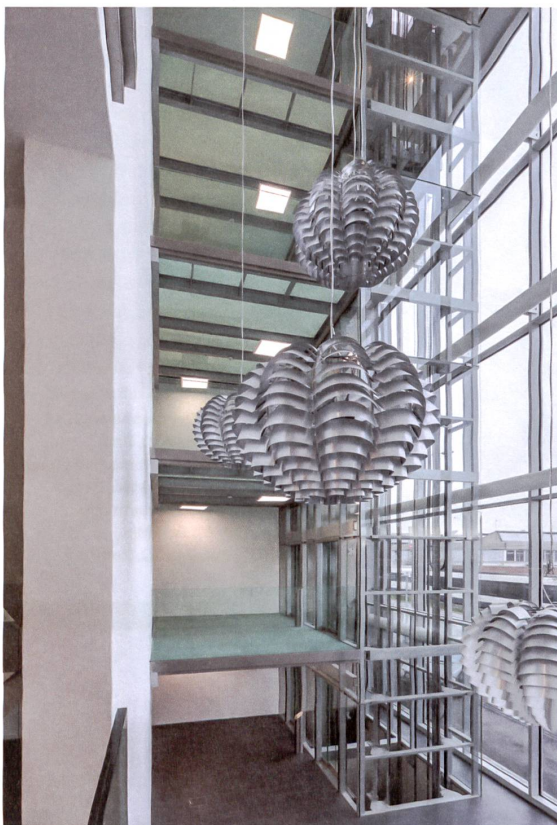
Auch der Liftschacht und die Zwischenpodeste stammen von Emch.
