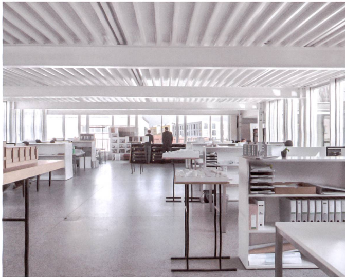
Stahlrahmen, Trapezbleche, geschliffener Beton – und jede Menge Tageslicht.
