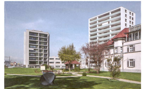
Kreuzlingen: Zwei neue Hochhäuser im Bahnhofsgebiet stehen ohne Bezug nebeneinander.
