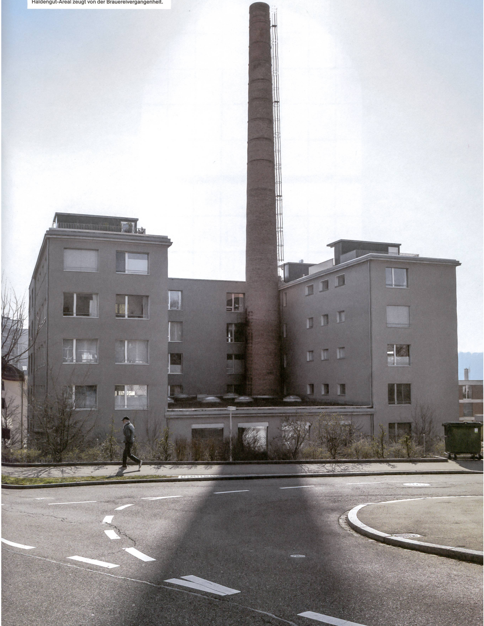
Der Hochkamin im Hof des Wohnhauses auf dem Haldengut-Areal zeugt von der Brauereivergangenheit.
