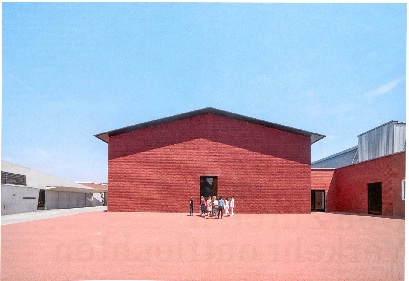
Das ziegelrote Haus mit einem filigranen, textil wirkenden Kleid steht erhöht im Industriequartier in Weil am Rhein. Nur die Eingangstüre durchbricht die geschlossene Fassade.
