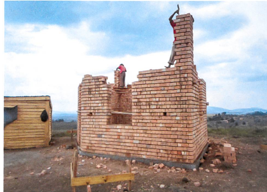
Schulhausbau in Madagaskar: Geld und Baupläne stammen aus Zürich.
