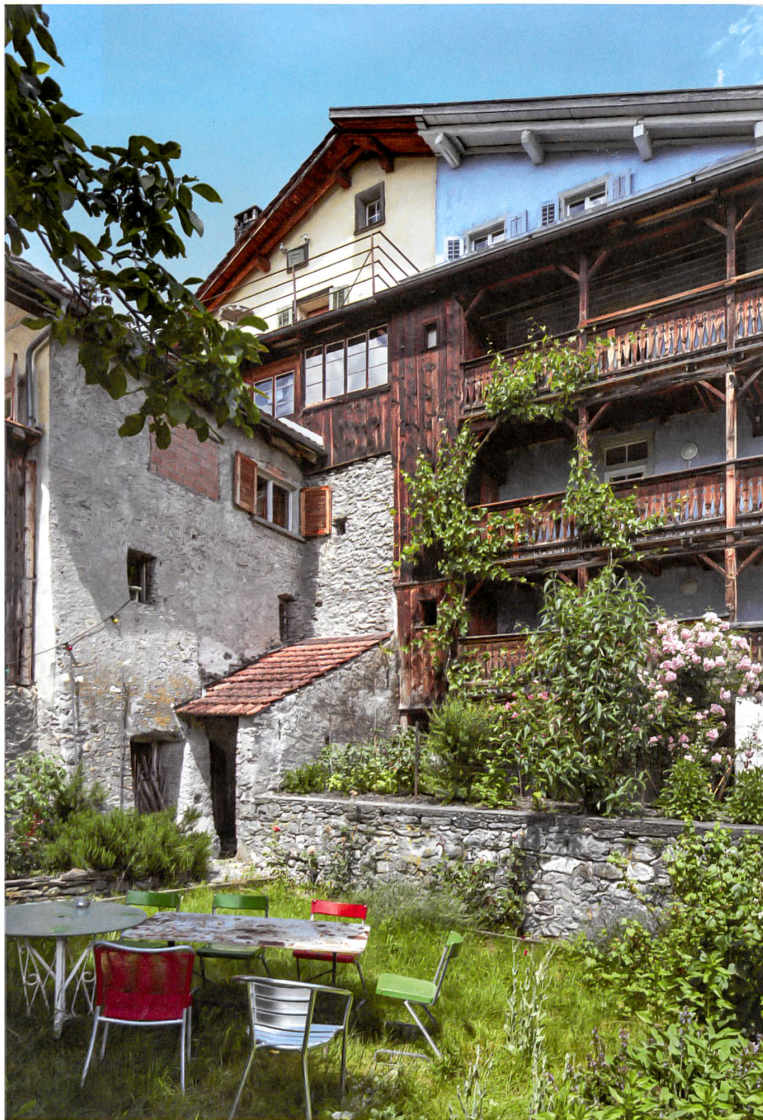
Renoviert statt abgebrochen: zauberhafte Hinterhöfe mit Lauben und Gärten.
