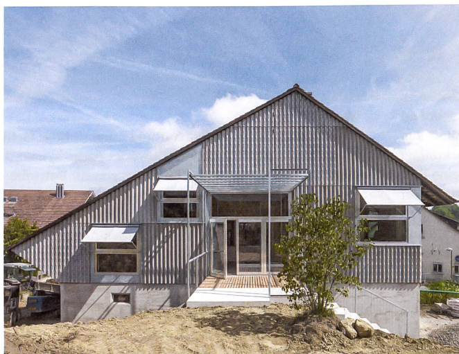
Ländliche Materialien in Iberg bei Winterthur: In der Eternitverkleidung sind die verzinkten Fenster frei verteilt. Aussparungen bringen Licht in die unbeheizten Bereiche.
