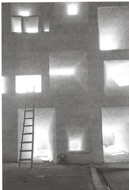
Lichtscharten in der Südwand der Kirche Notre Dame du Haut in Ronchamp, während der Bauzeit, 1955.
