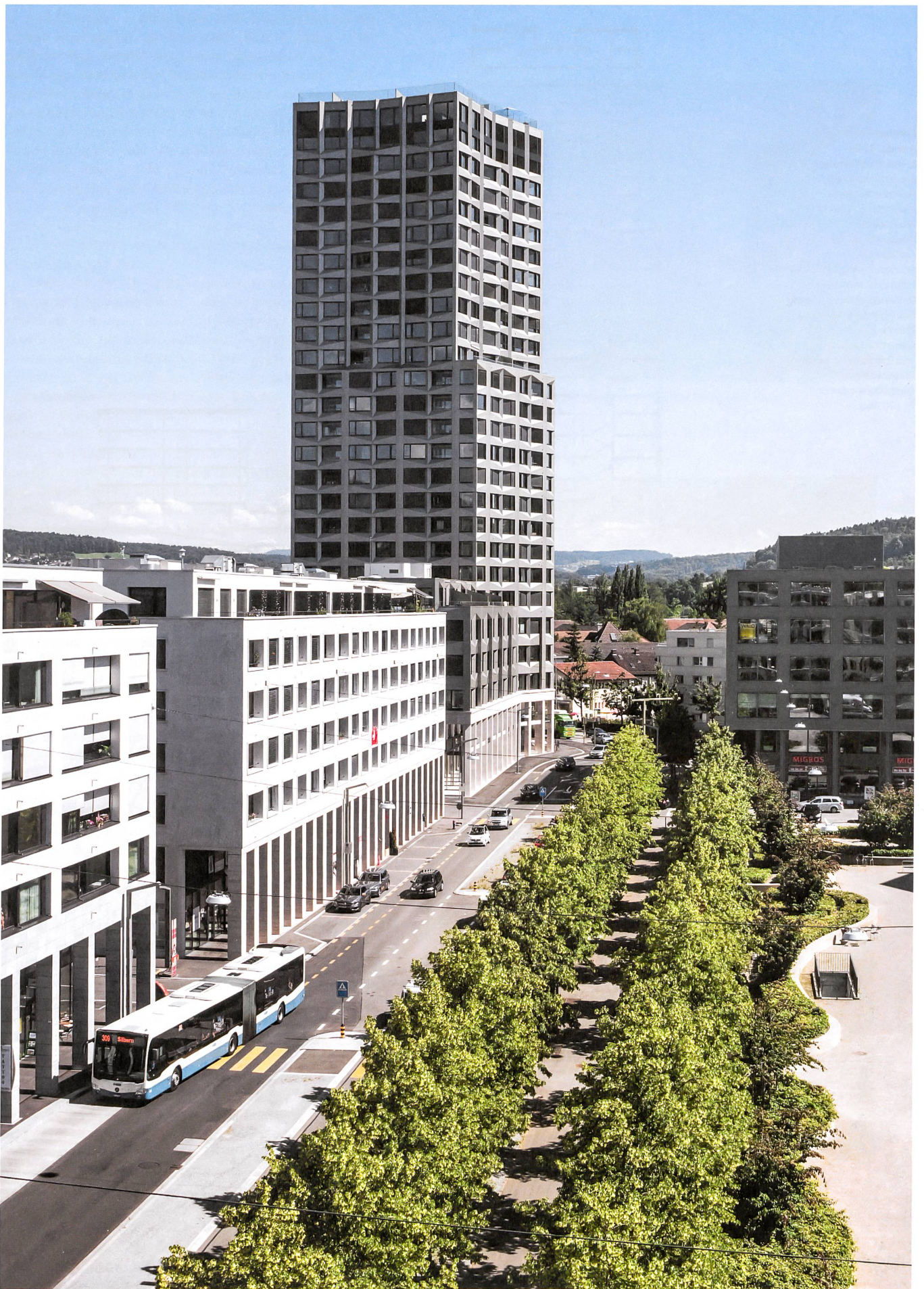
Der Limmat-Tower verankert das Limmatfeld in Dietikon dank seiner polygonalen Form und Fassaden in fünf Richtungen.
