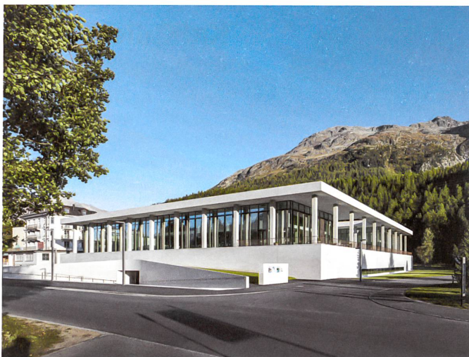
Die umlaufende Säulenreihe des Hallenbads in St. Moritz trägt die grosse Dachplatte und erinnert an einen Tempel.
