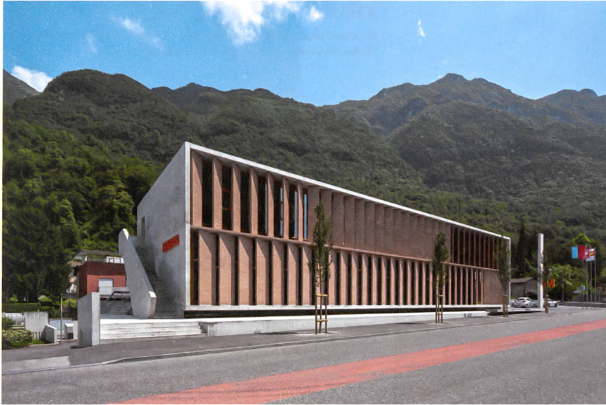
Hinter den Backsteinscheiben befindet sich oben die Gemeindeverwaltung von Melano, unten eine Migros-Filiale.
