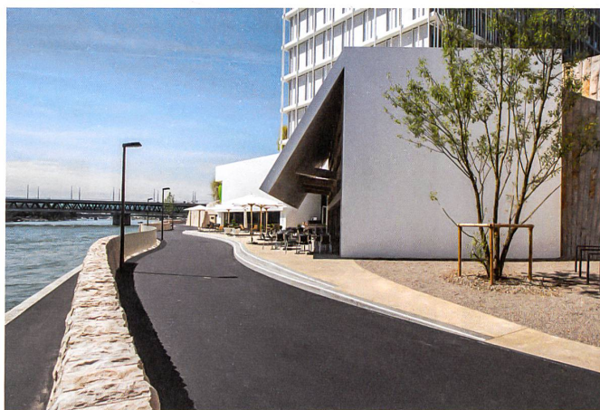
Oben ist der Weg hochwassersicher und nachts beleuchtet. Unten verläuft die Promenade direkt am Wasser.
