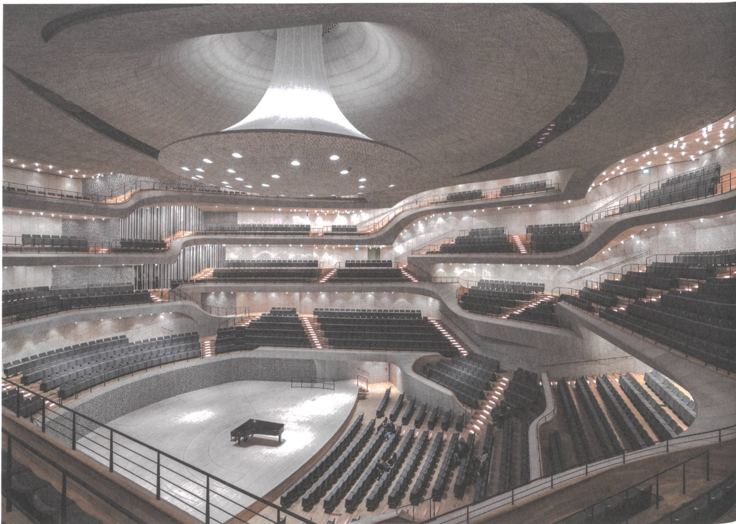
Die Haut des Konzertsaals besteht aus 10 000 computergesteuert gefrästen Gipsfaserplatten, die den Schall perfekt verteilen.
