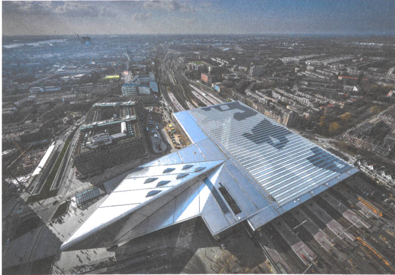
Das Faltdach markiert den Haupteingang, das gläserne «Gewächshaus» deckt die Bahnsteighalle. 130 000 Solarpaneele sind zu einem dunklen, unregelmässigen Muster im Glasdach angeordnet.
