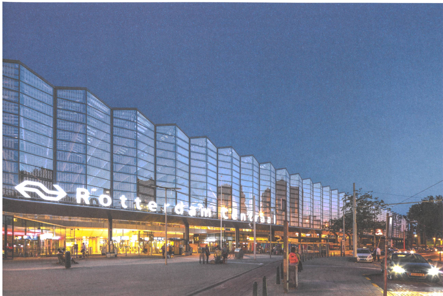
Das Nordportal ist klar die Rückseite des neuen Bahnhofs. Das Faltdach der Bahnsteighalle geht hier in die Vertikale über.
