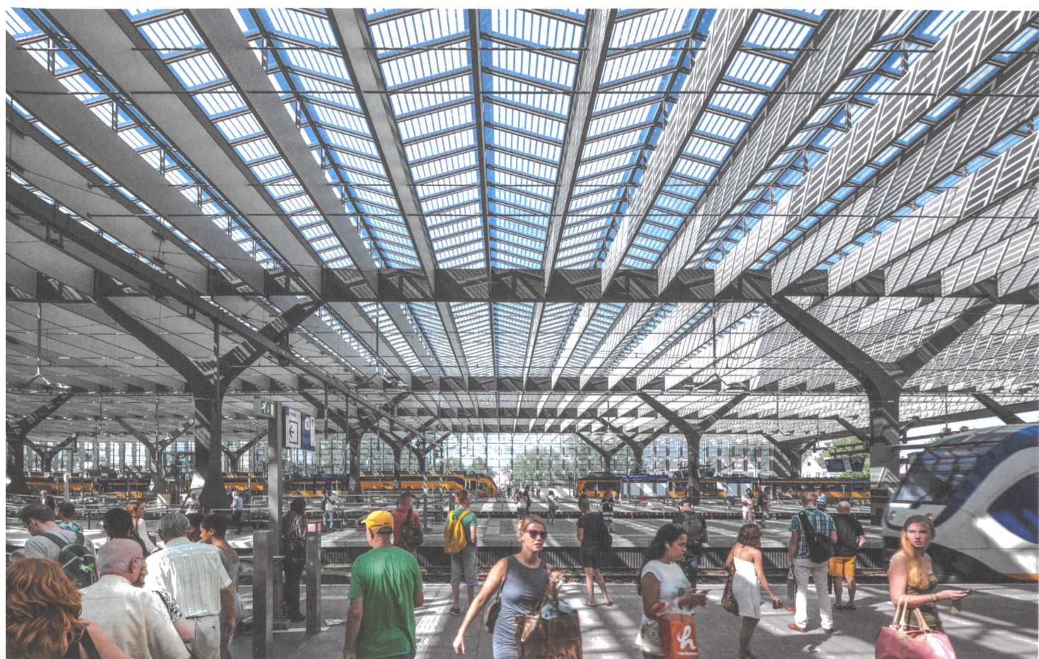
Grund für den Neubau war ein gewaltiger Kapazitätsausbau: Rotterdam rechnet mit bis zu 323000 Besuchern pro Tag, die in zehn Jahren die Perronhalle benutzen werden.
