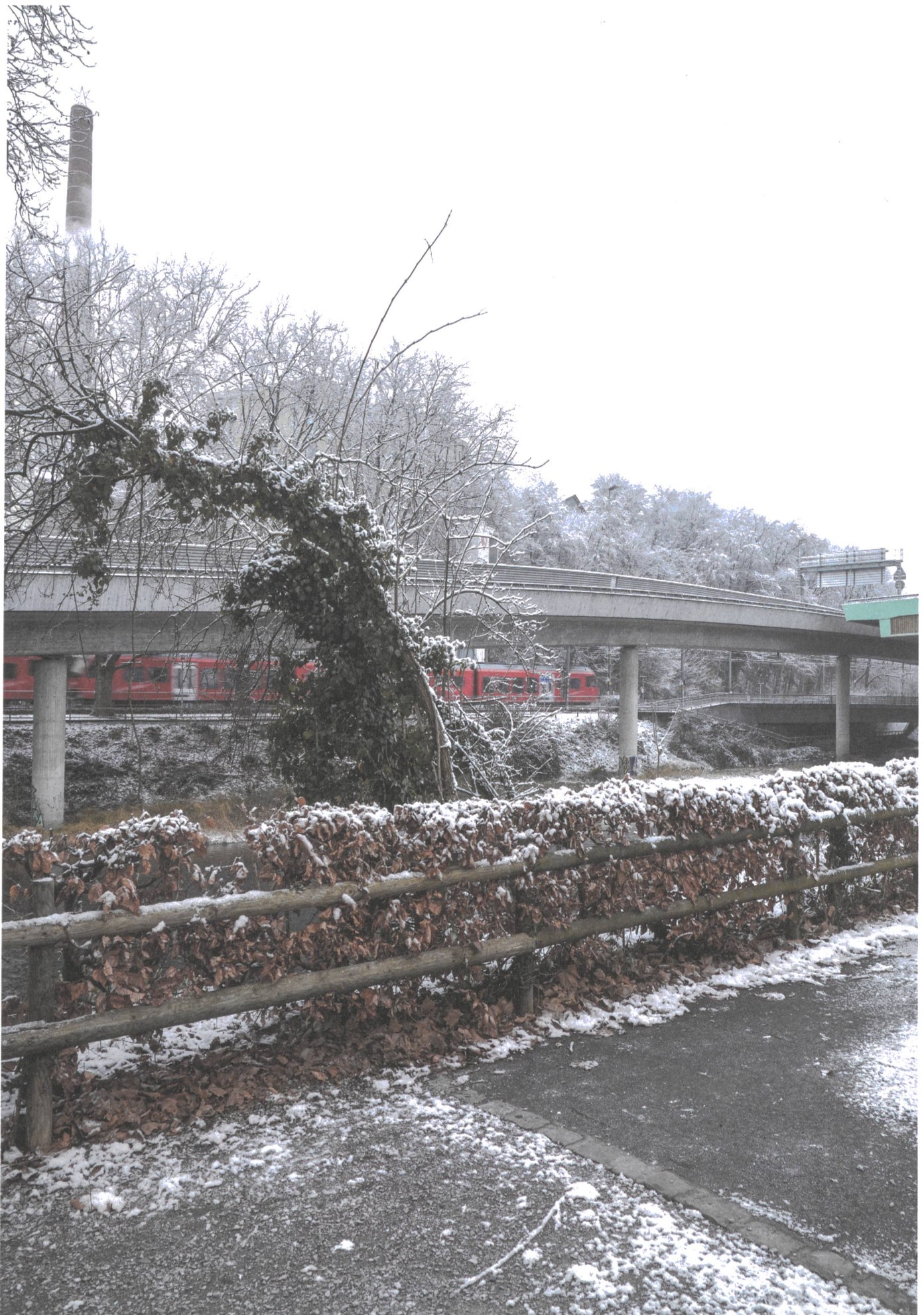
Schienen, Fluss, Autobahzubringer – ein auf den ersten Blick unmöglicher Ort fürs Wohnen auf Zeit: der Bauplatz in Zürich.
