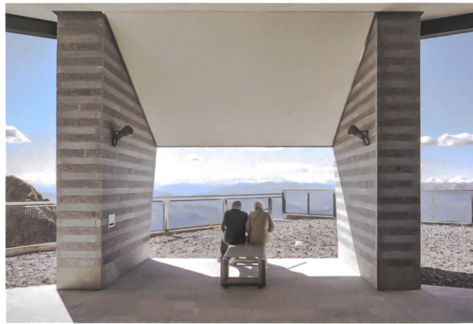
Das Gebäude ruht auf massiven Stützen, die das Erdgeschoss freispielen.
