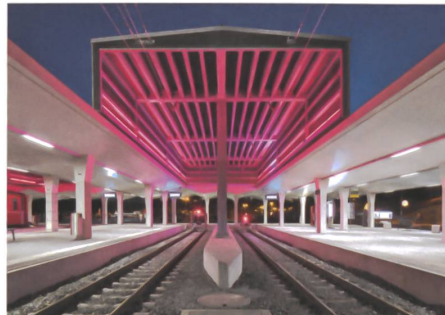
Unter den farbig in die Nacht leuchtenden Dächern aus Kunststoff werden die Lokomotiven parkiert.
