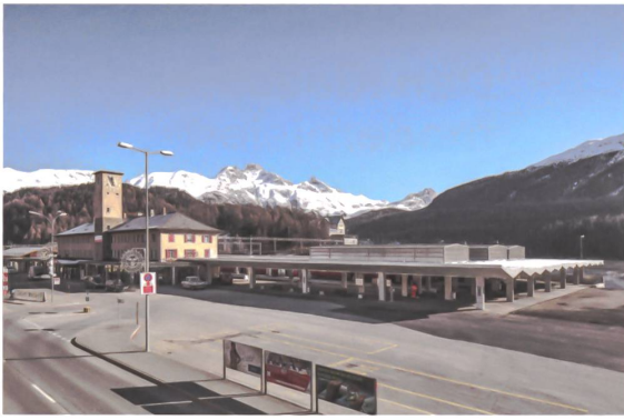
Erneuerter Kopfbahnhof in St. Moritz.
