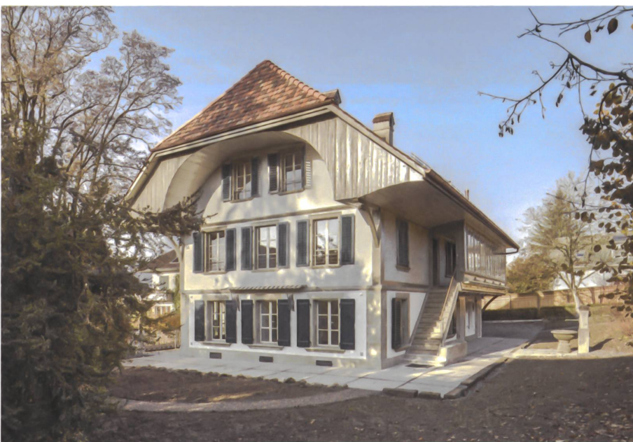
Schweres Krüppelwalmdach mit «Bernerrüdi»: Das Haus am Tavelweg in Muri bei Bern erstrahlt in alter Frische.
