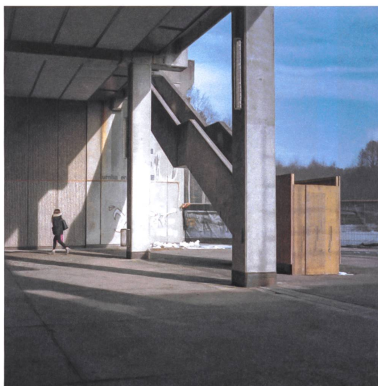
Die Treppe beim Eingang muss einem neuen Hauptzugang weichen.
