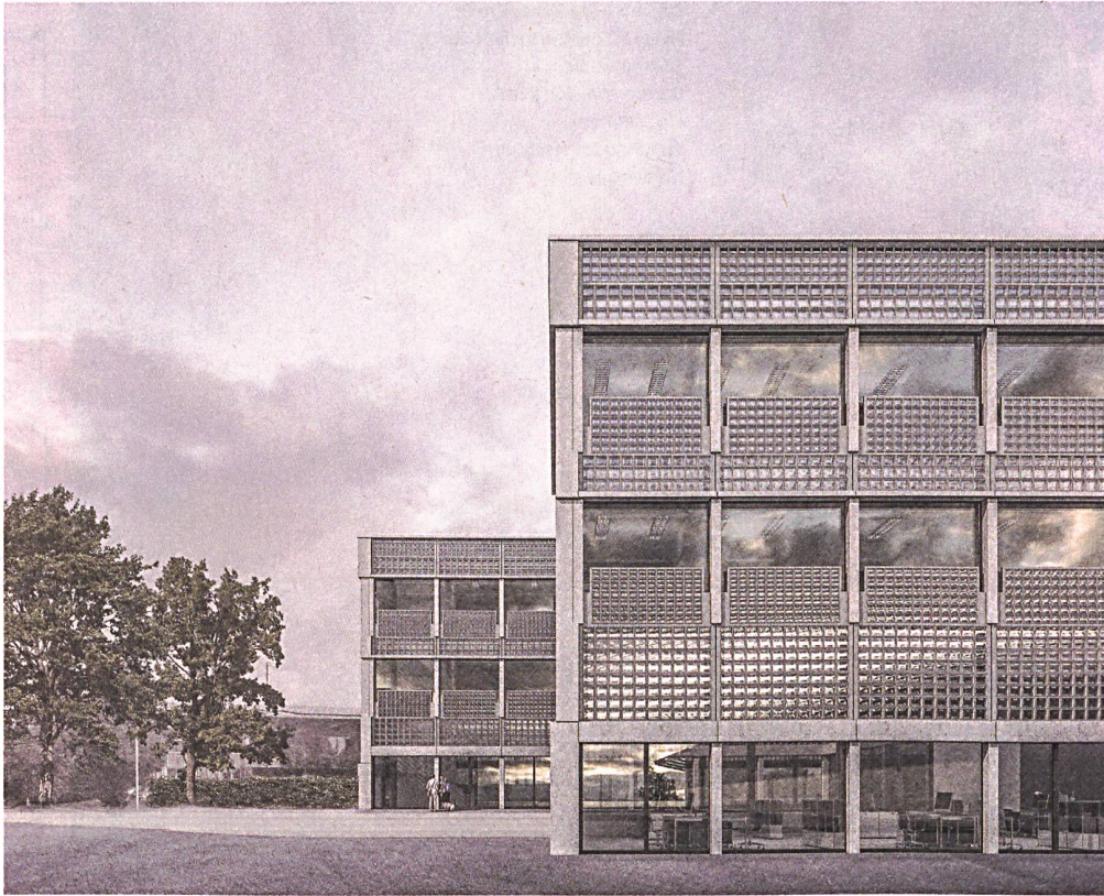
Auch beim Bürogebäude in Zug kommen Glasbausteine zum Einsatz.
