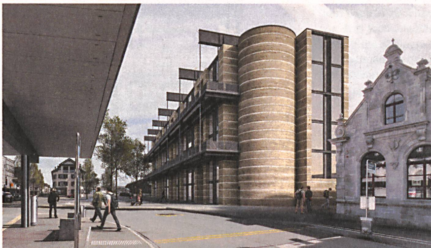
Die Zylinder bergen die Treppenhäuser und die haushohen Wärmehäuser.
