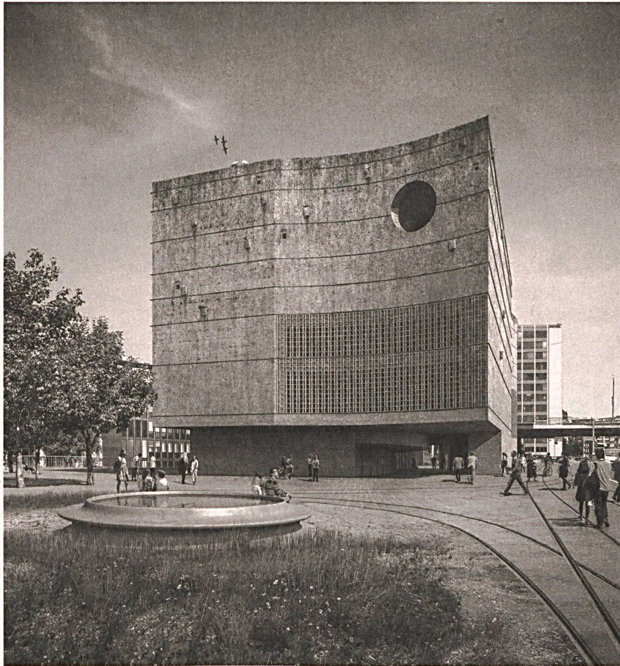
Beim Ozeanium in Basel soll die Lehmfassade helfen, das Wasser der Aquarien zu kühlen.
