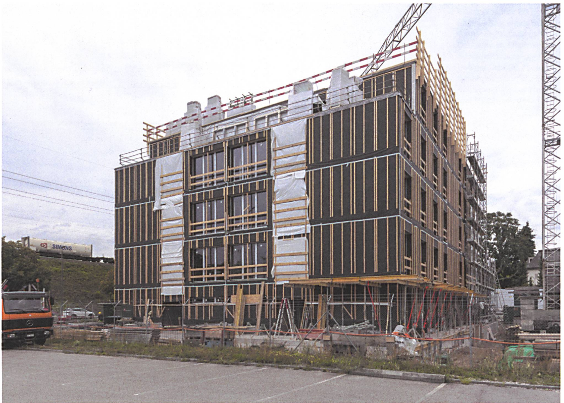
Das Gebäude ist aufgerichtet, noch fehlt die Fassade.
