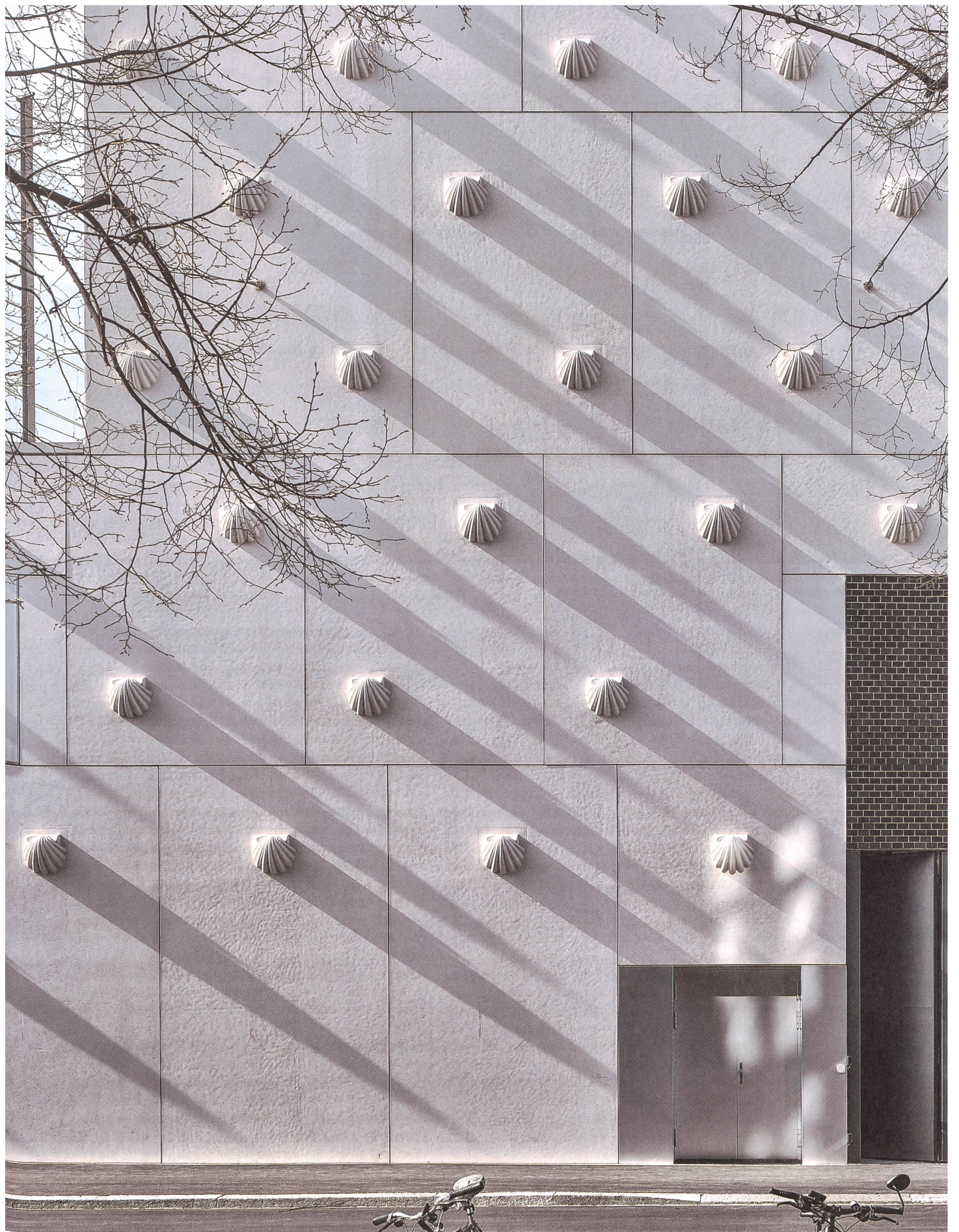
Die Jakobsmuscheln sind aus massivem Beton gefertigt und mit Faserbetonplatten vergossen. Sie schmücken die Hauptfassade und lenken vom Fugenbild ab.
