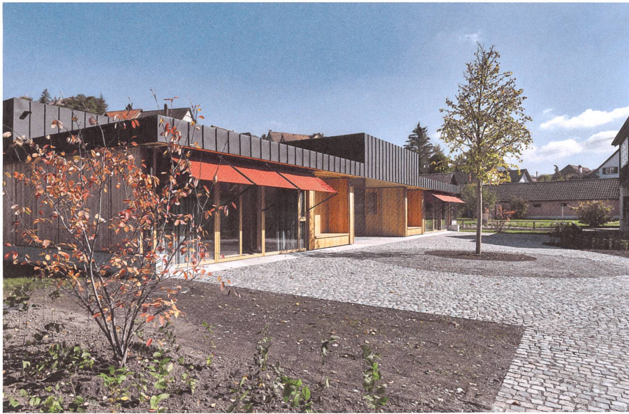
Auf dem Flachdach verbergen Kisten die Technik, zeichnen überhohe Räume ab und markieren den mittigen Eingang.
