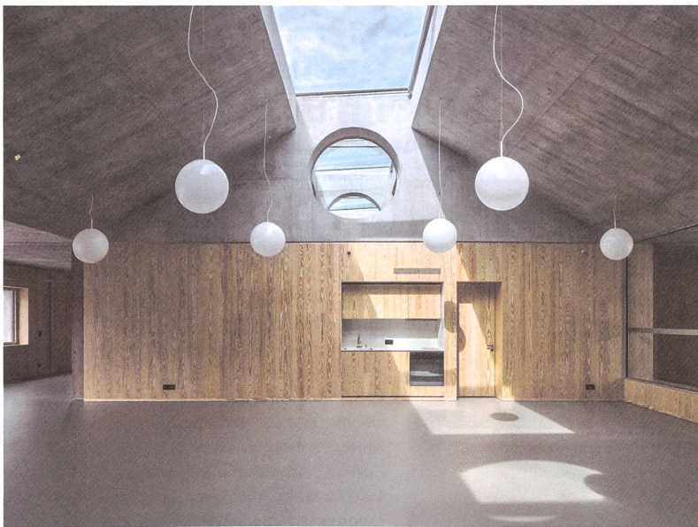
Ein mächtiges Betontragwerk überspannt die Räume bis zu den Aussenwänden.
