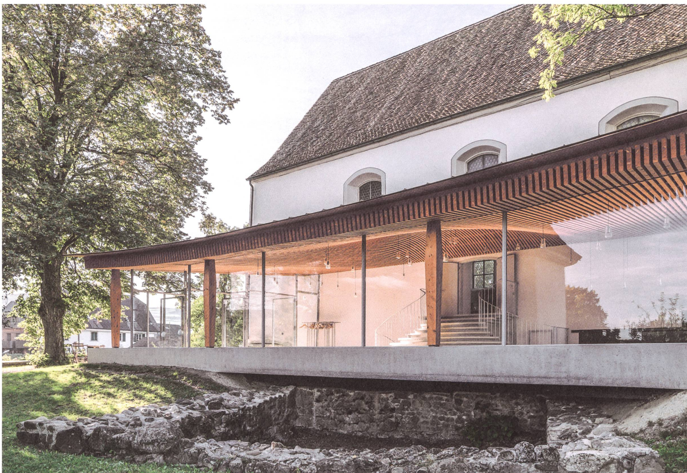
Konzertfoyer Boswil: Ein Betonbalken hebt die Eingangshalle über mittelalterliche Fundamentreste und dient zugleich als Sitzbank.
