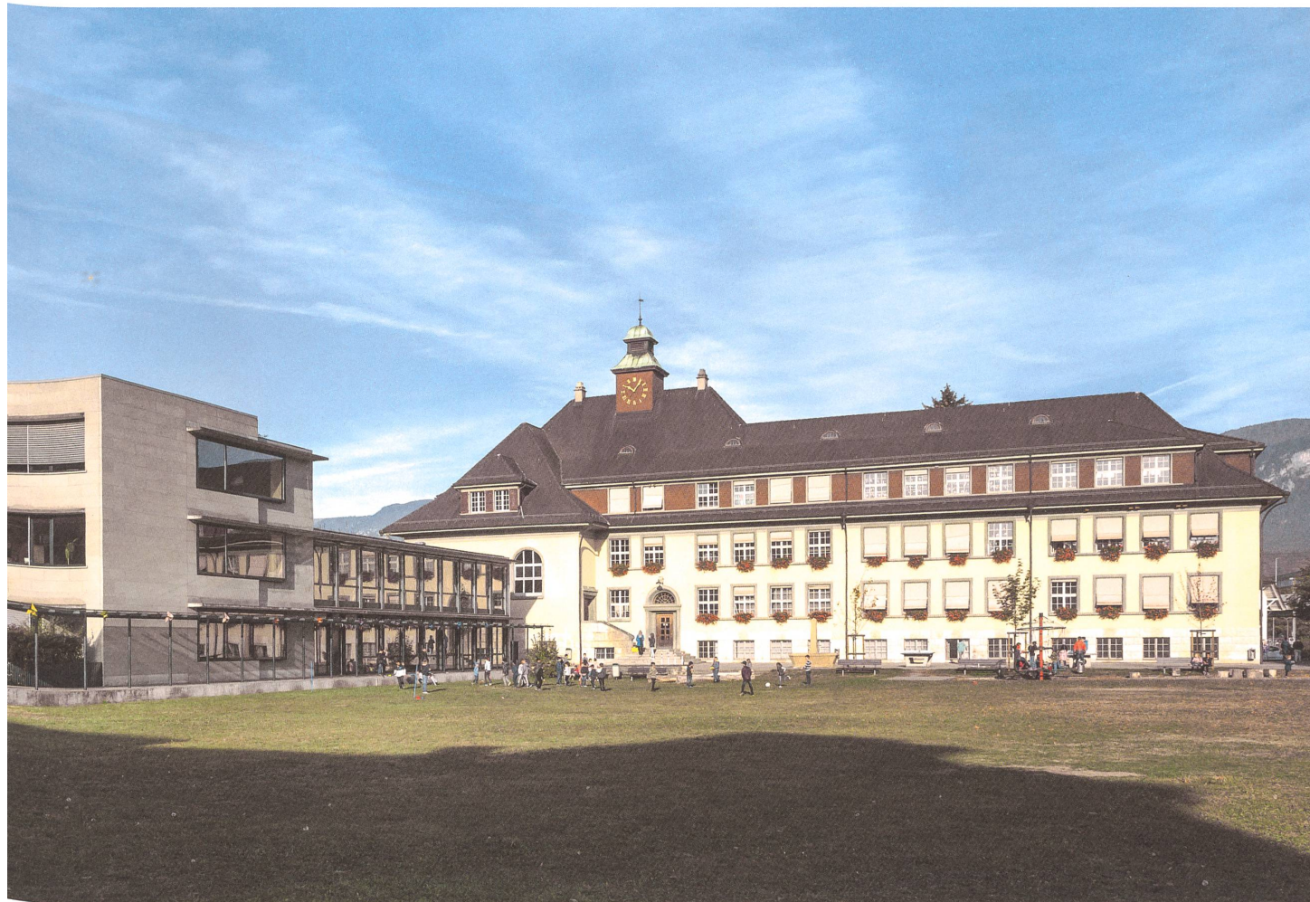
Das 1926 erbaute Schulhaus Pisoni mit dem Erweiterungsbau aus dem Jahr 1996.
