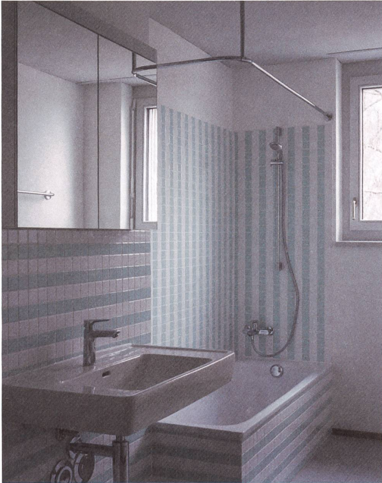
Wo das Wasser fliesst, sind die gefliesten Streifen vertikal, sonst horizontal.
