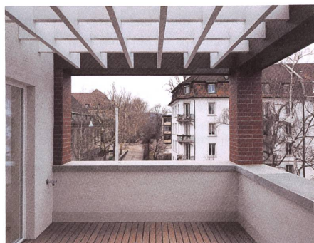
Ziegelstützen? Darin verstecken sich Holzstützen.
