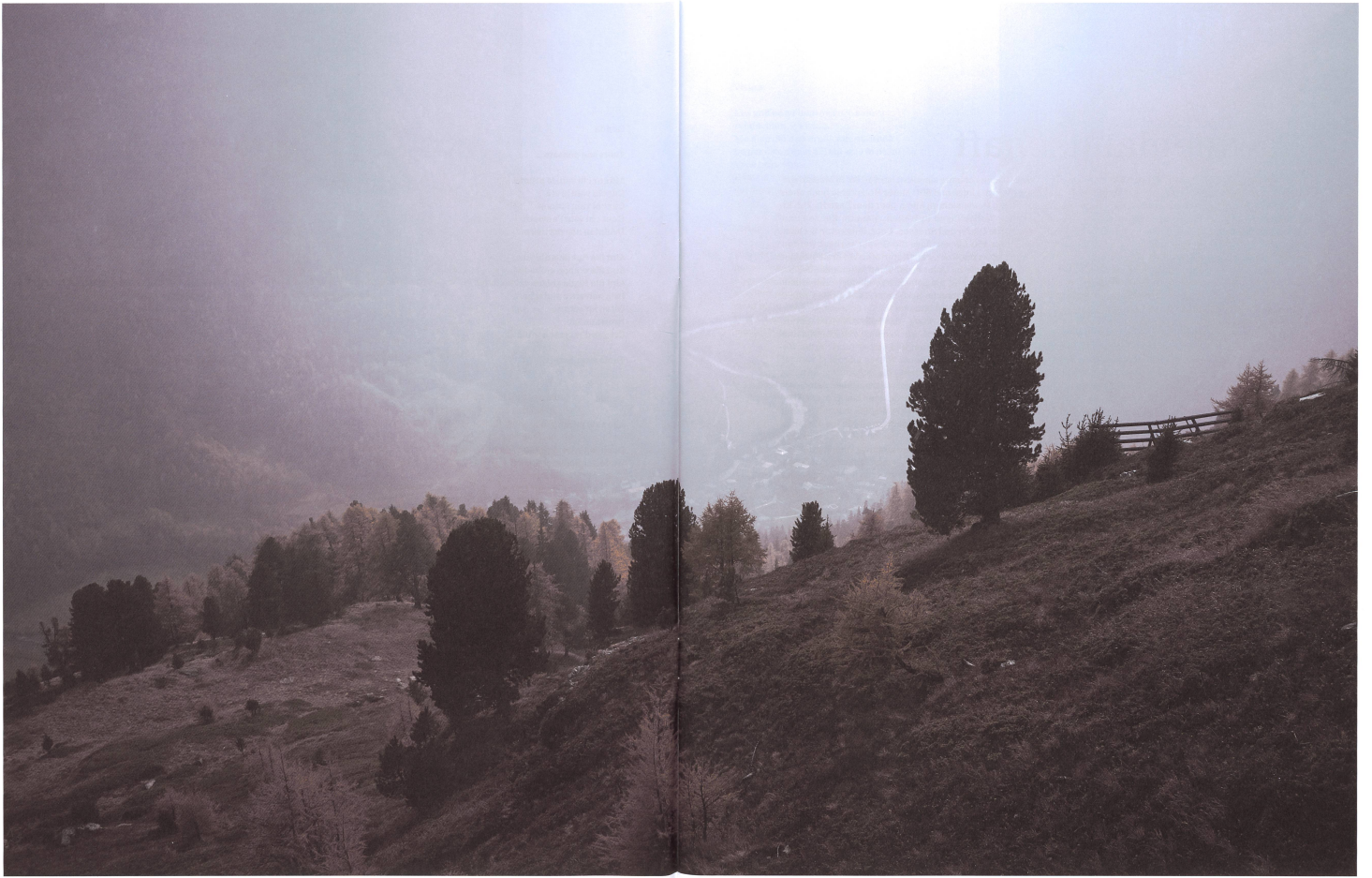
Lawinerverbauung unter dem Piz Chastè zwischen Susch und Lavin.
