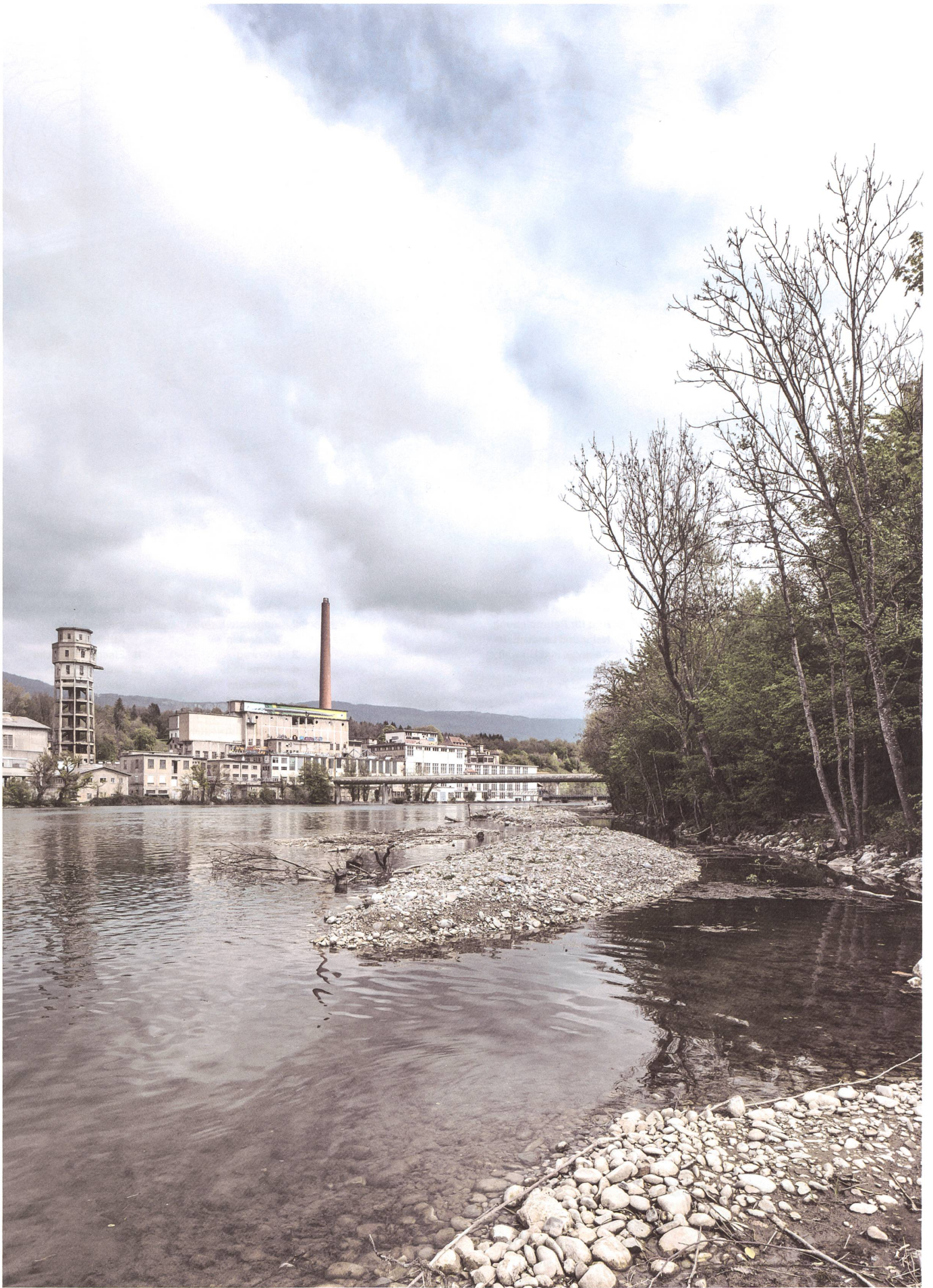
Vor dem Aareufer sind Kiesinseln aufgeschüttet, die vielfältige Laich- und Nistplätze bieten. Dahinter ragt der Industriekomplex der ehemaligen Cellulosefabrik Attisholz auf.
