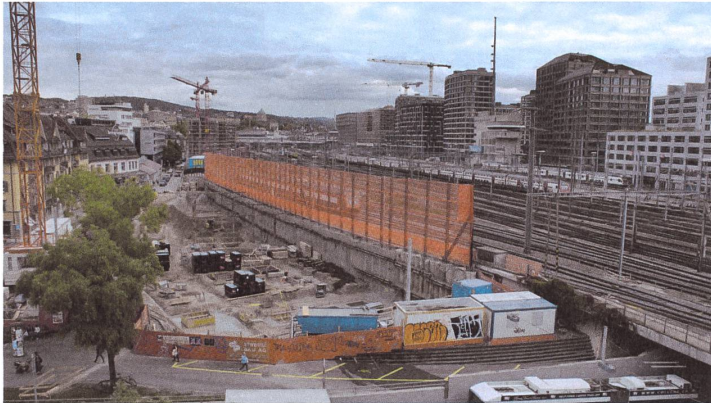
Baustelle des Zollhauses gegenüber der Europaallee am Zürcher Gleisfeld.
