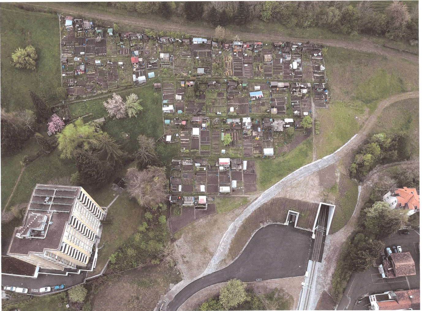
Ruckhalde aus der Luft. Der neue Bahntunnel ermöglicht eine Wohnüberbauung, wo heute gegärtert wird.
