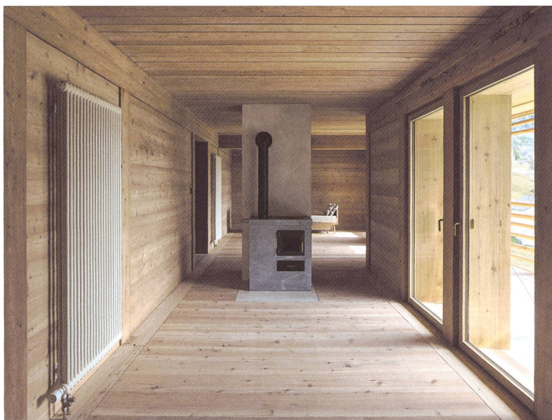
Noch mehr Holz: Daumendick bekleidet Lärchenholz sämtliche Böden, Decken und Wände.
