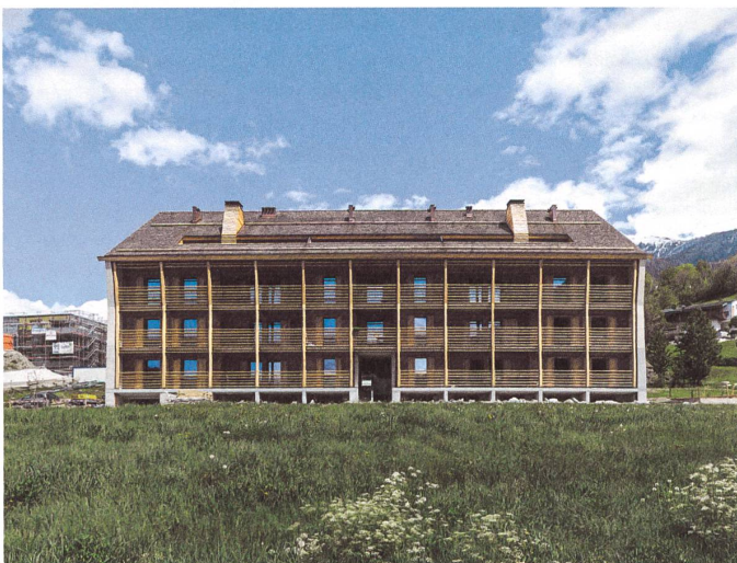
Waiserhaus neu interpretiert: Mantelmauern aus Beton rahmen den Lärchenholzbau.
