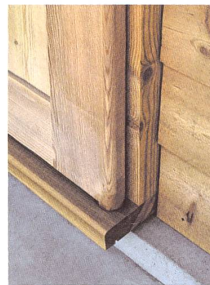
Holz: Selbst die Dübel sind aus Walliser Lärche.
