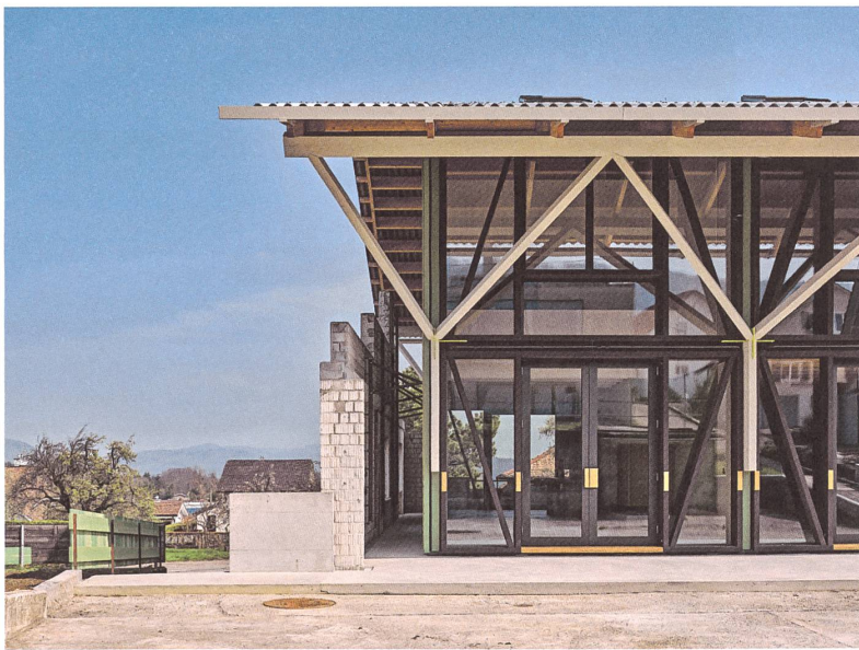
Dem filigranen Haus im solothurnischen Nuglar geben Mauerreste eines ehemaligen Weinlagers Halt.
