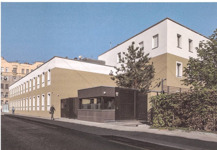
Die Strassenfassade der neuen Schweizer Botschaft gliedert sich ins Moskauer Stadtbild ein.
