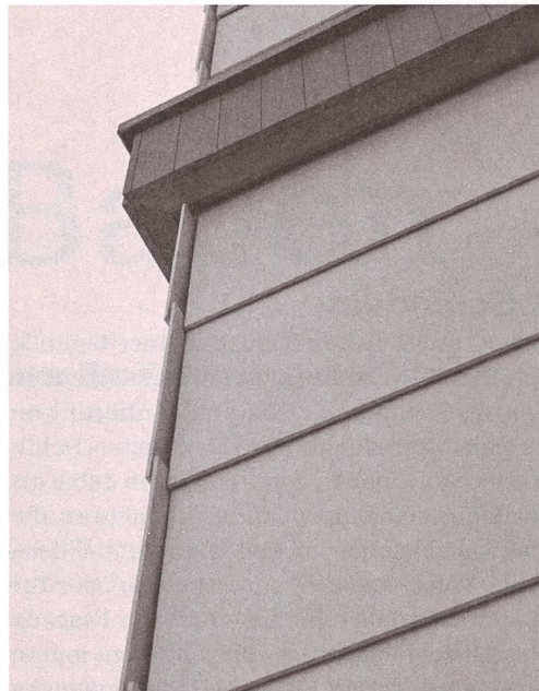
Flächig und zerbrechlich: die Eternittafeln des Mehrfamilienhauses in Zürich-Oerlikon von Lütjens Padmanabhan.
