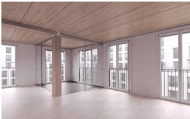
Sichtbare Stützen und Balken zeigen, wie der Holzbau trägt.
