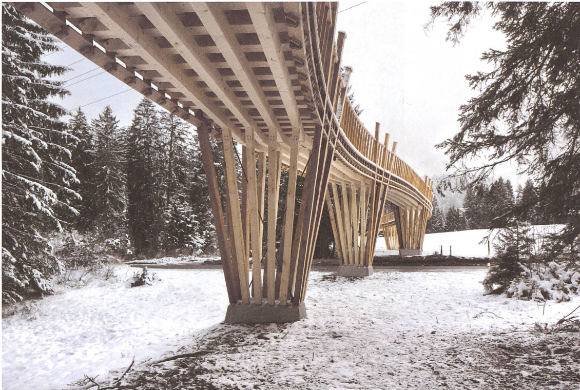
Ein Stützenwald als Sprengwerk und ein Holzstapel entlang dem Waldsaum von Laax-Staderas. Foto: Ralph Feiner
