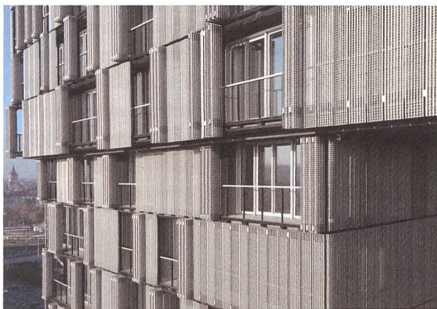
Von nahem zeigt sich die Dimension der Metallstoren. Foto: Herzog & de Meuron
