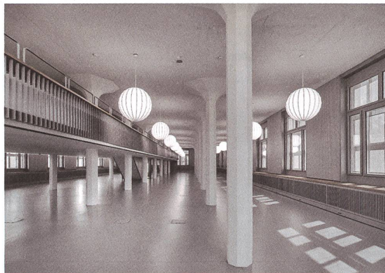
Die Tragstruktur des Altbaus von 1931 mit den Pilzstützen blieb erhalten.
