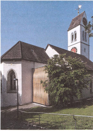
Die angebaute Kapelle in Winterthur wurde fast vollständig aus wiederverwendetem Material von Asylunterkünften gebaut.
