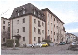
Vor der Sanierung: kleine Fenster und ein Eternitkleid.
