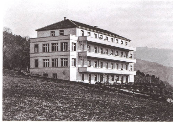
1 Der Pavillon Nadenbousch für Tuberkulosepatienten war 1930 das erste Spitalgebäude im Beaumont-Quartier Biel. Foto: Archiv Spitalzentrum Biel
