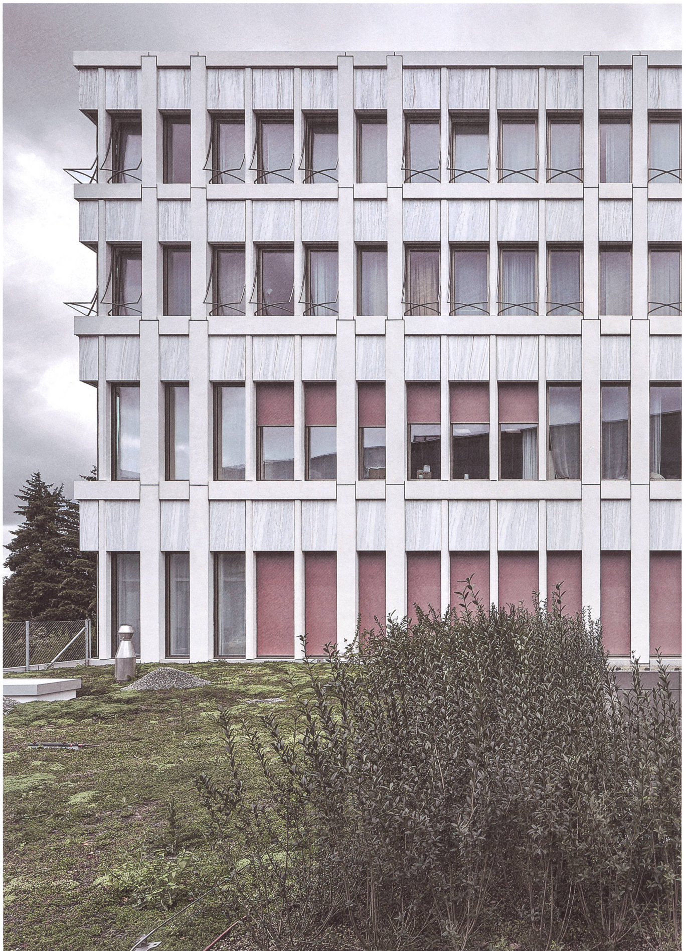
4 Weisser Beton, weisser Marmor, dunkles Rot: Die noble Materialkombination für das Organzentrum des Inselspitals Bern. Foto: Kuster Frey
