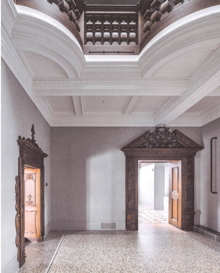
Der wieder offene Vorraum des Lochmannsaals. Die Stuckatur überspielt die Asymmetrie, darüber das rekonstruierte Geländer.
