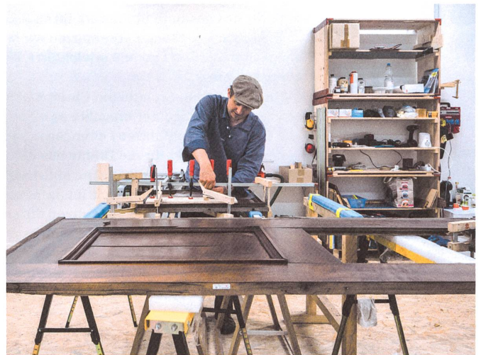
Gelöste Rahmenteile und Holzverbindungen wurden neu verleimt und wo nötig verstärkt.
