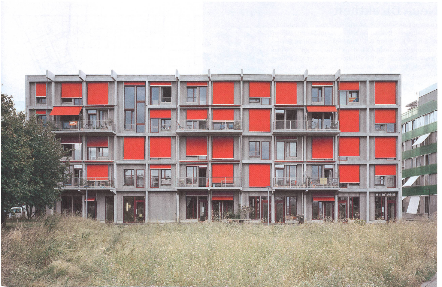
Betonskelett und Welleternit sind industriell, Fensterrahmen und Sonnenstoren farbig-wohnlich. Das Haus, gesehen vom Park aus.
