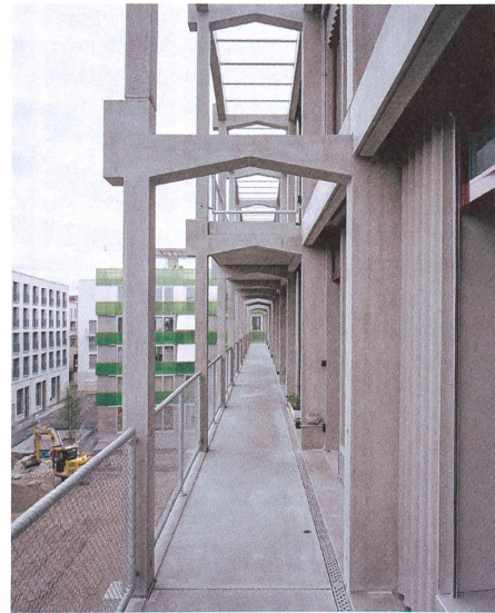
Zum Hof richten sich Laubengänge und Balkone.
