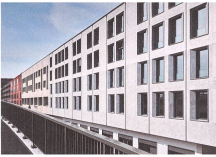
Variierende Fenstergewände beleben die Fassaden.
